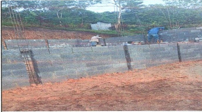
Foto1: Instalación de pared en módulo tipo pórtico
