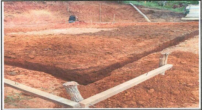
Foto 2: Instalación de cemento corrido de block
