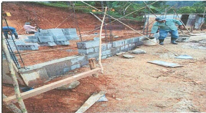
Foto 3: Instalación de puerta de metal
